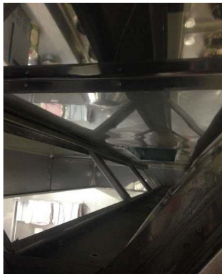
Innenansicht der Dunstabzugshaube ohne UV-System
