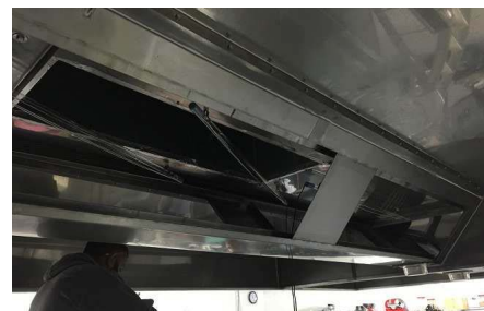
Innenansicht der Dunstabzugshaube mit UV-System
