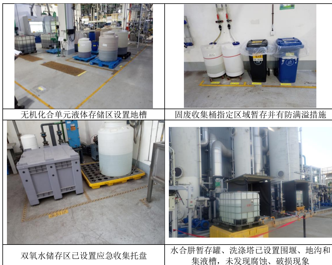
图 4.3-2 RC/CP 生产线现场照片
