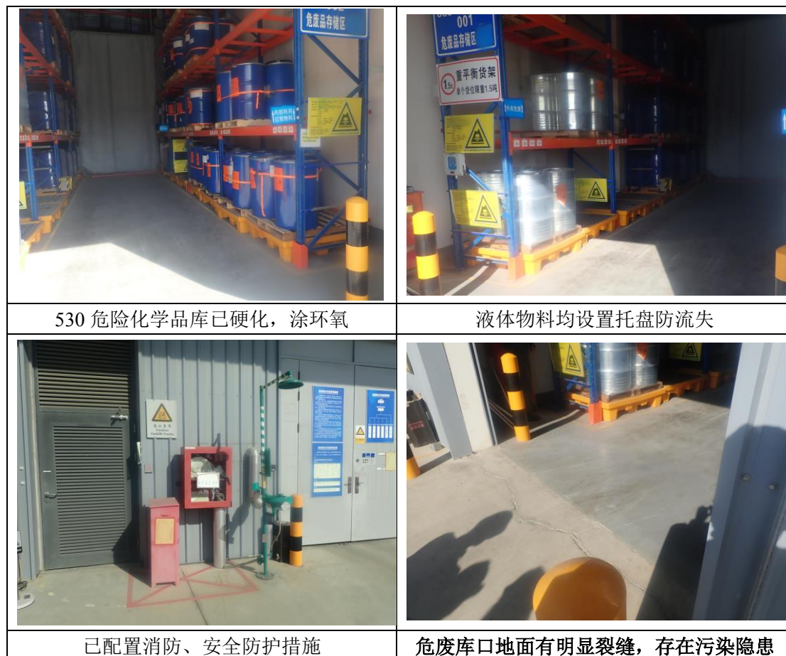
图 4.1-6 危险化学品库现场照片
