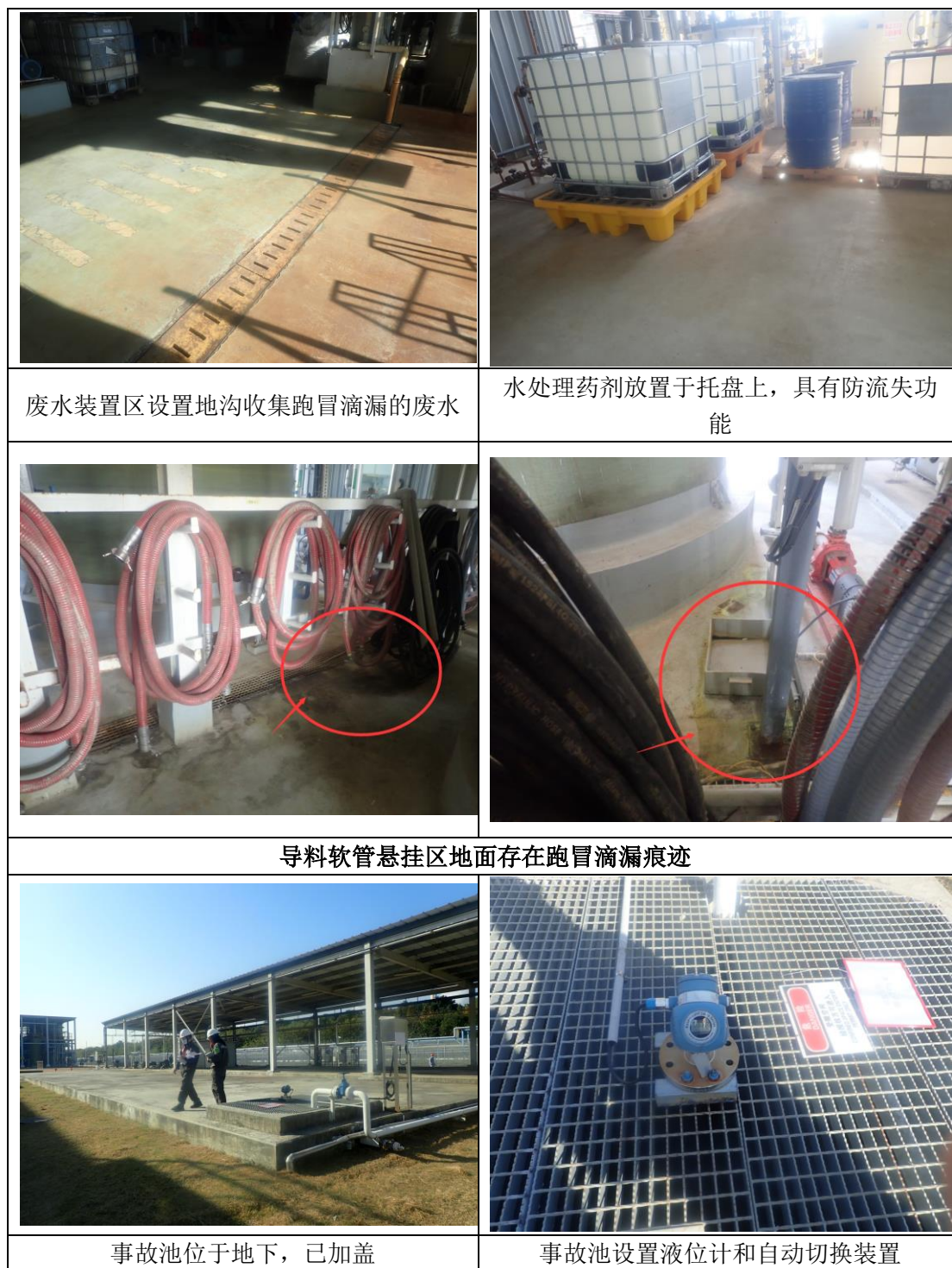
图 4.1-8 污水处理区现场照片
