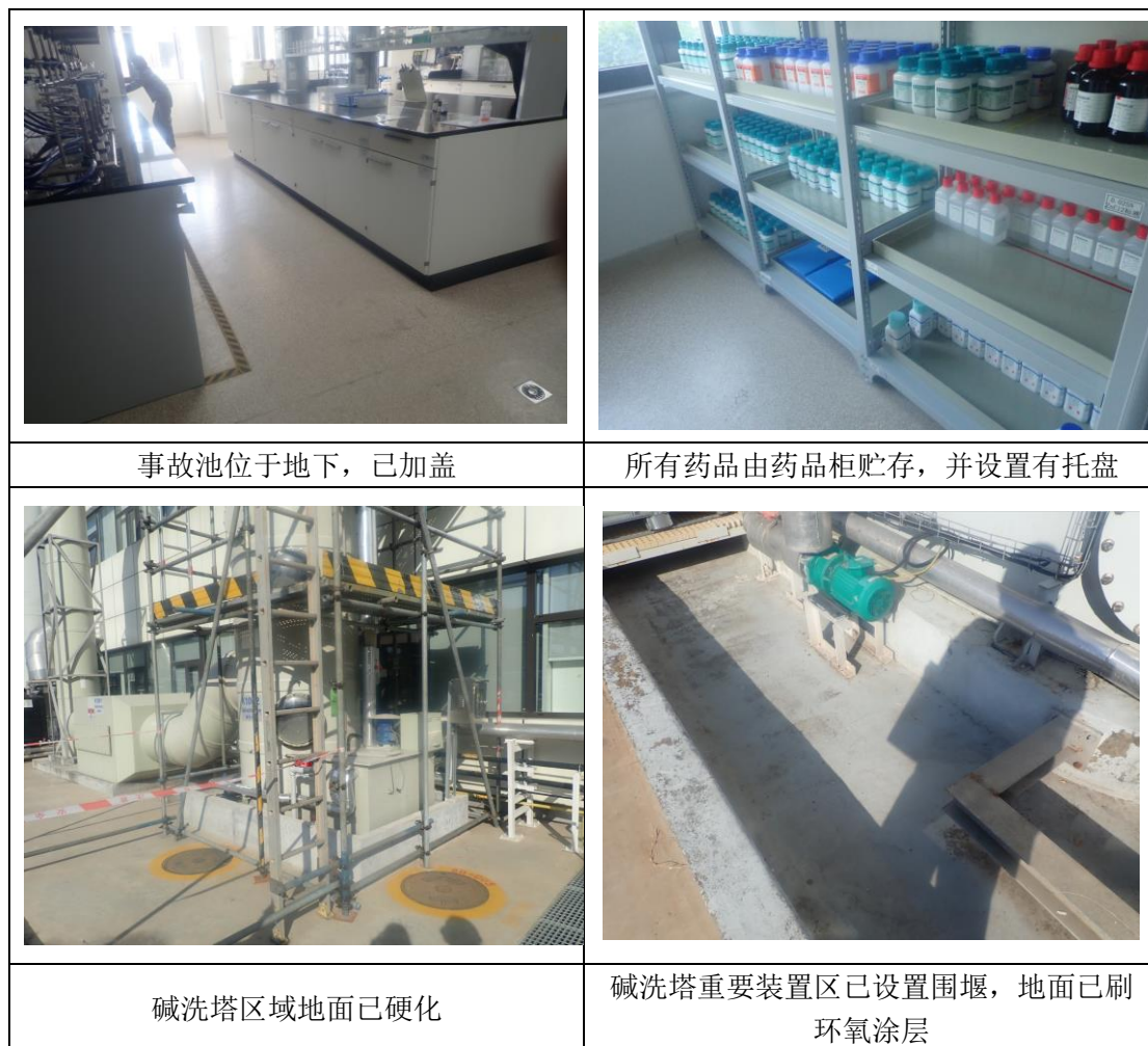
图 4.1-9 污水处理区现场照片
